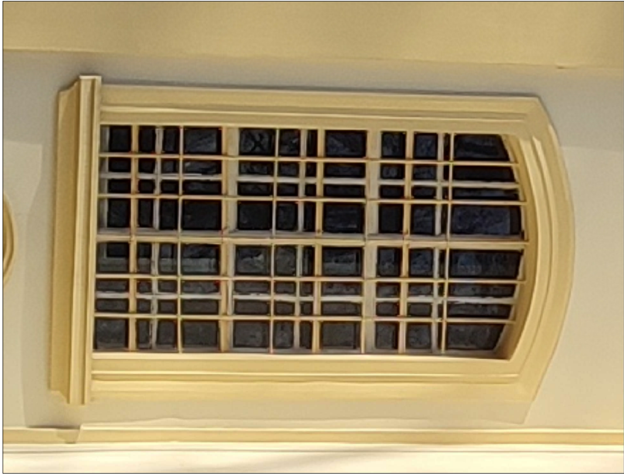
ZDJĘCIE OKNA ISTNIEJĄCEGO WIDOK OD WEWNĄTRZ
