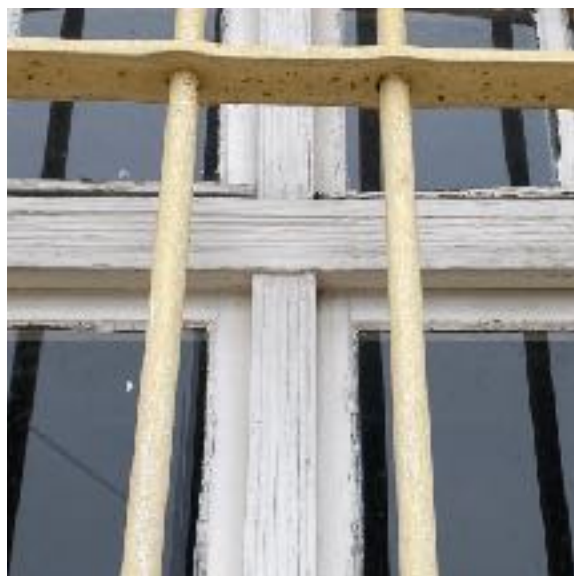
Fot. 5 Zbliżenie na detal profili okna - rowkowany przymyk i ślemię
