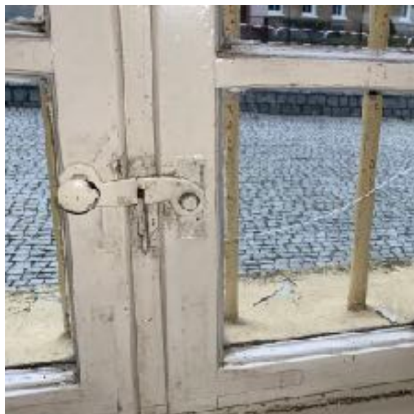
Fot. 6 Zbliżenie na system zamykania okna - zakrętkę dźwigniową
