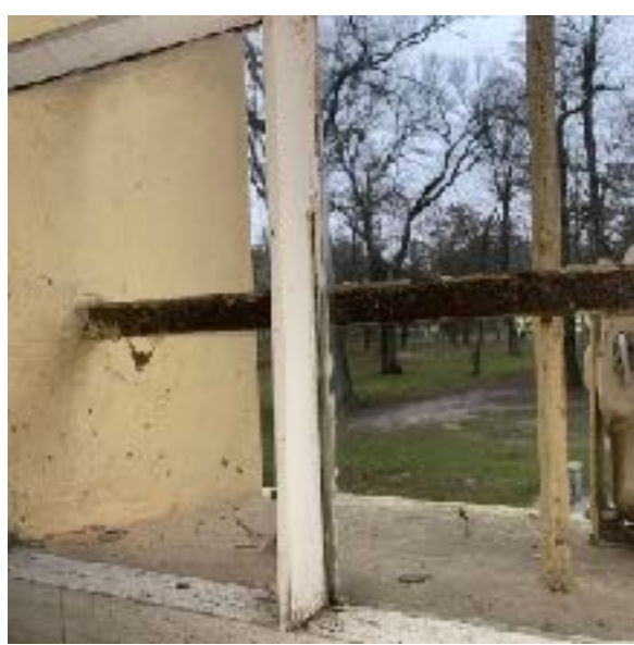
Fot. 6 Zbliżenie na szpros okienny z ukośnym fazowaniem i o wąskiej górnej płaszczyźnie
