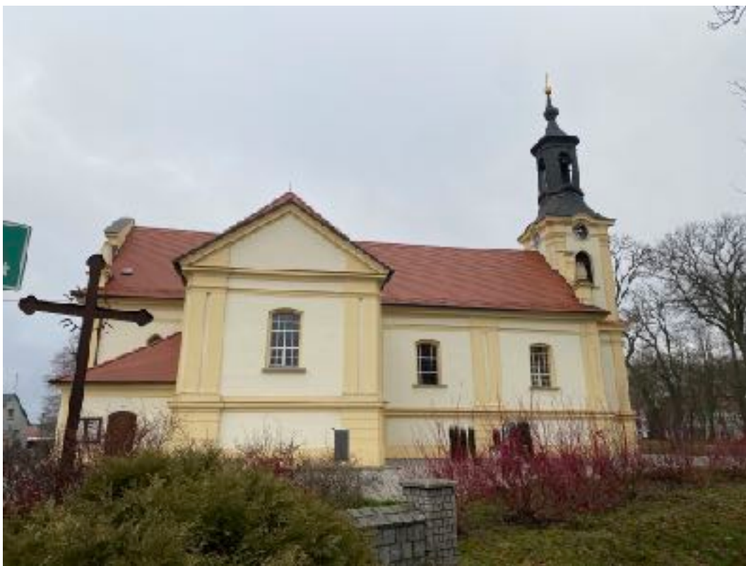
Fot. 4 Elewacja południowa kościoła pw. Św. Piotra w Okowach w Chobienicach.
