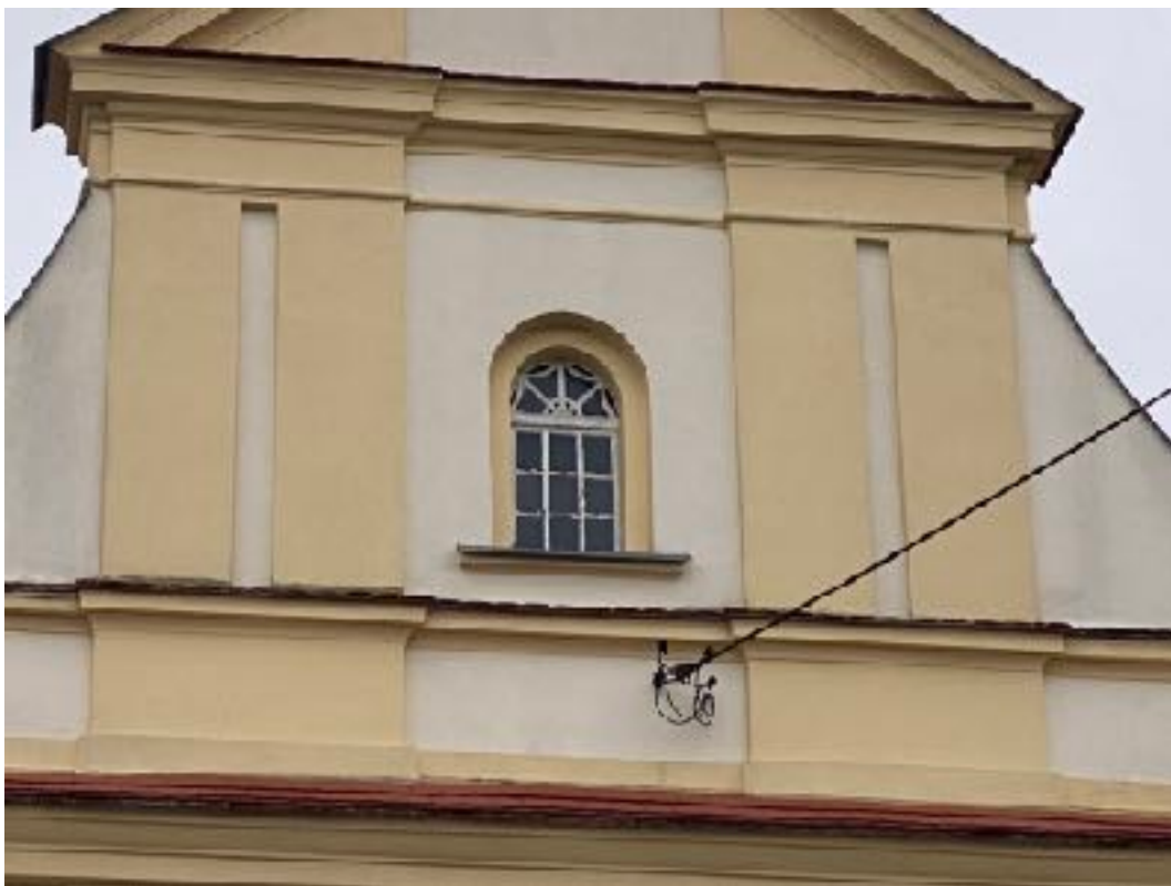
Fot. 5 Zbliżenie na okno nr 12 w elewacji zachodniej.
