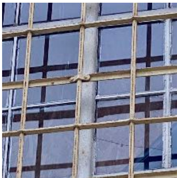
Fot. 5 Zbliżenie na pionowy słupek okienny o przekroju spłaszczonego wałka
