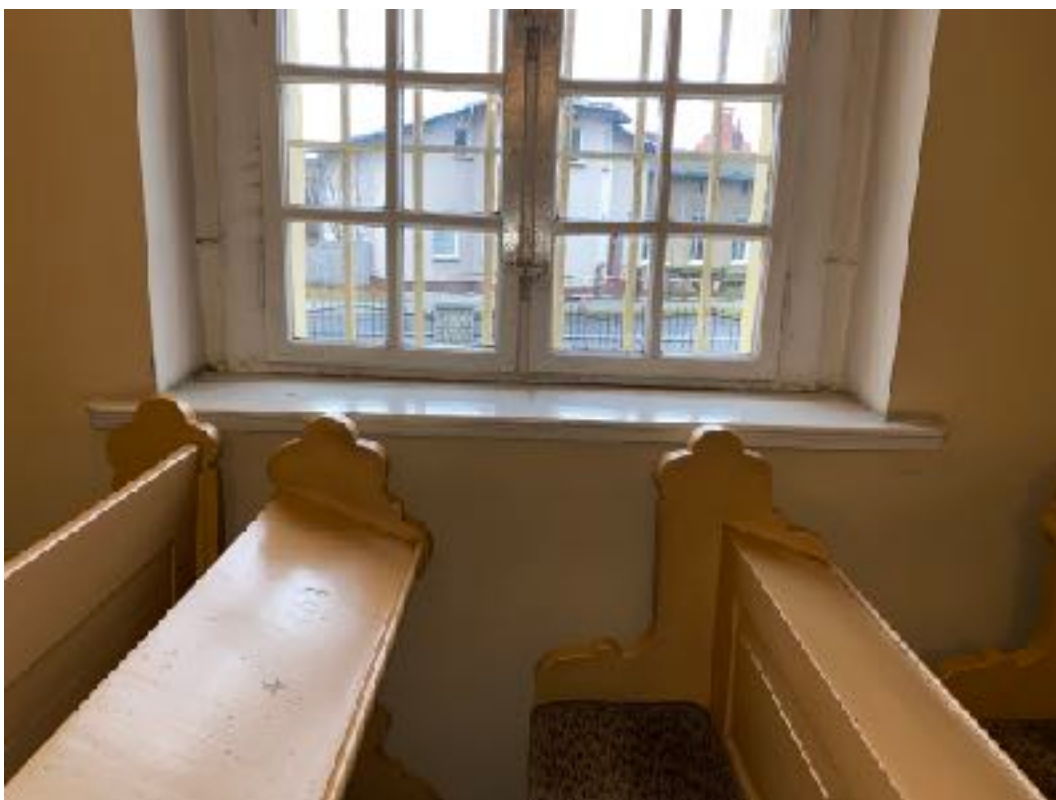
Fot. 8 Zbliżenie na drewniany parapet okienny okna nr 2 w elewacji zachodniej.
