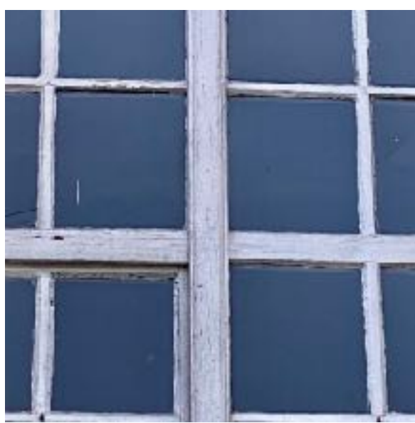
Fot. 8 Zbliżenie na pionowy słupek okienny o przekroju prostokąta o zaoblonych narożach na podkładce
