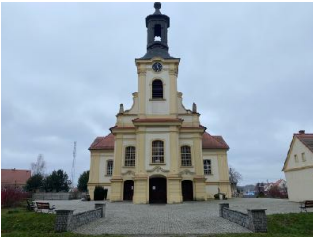
Fot. 3 Elewacja wschodnia kościoła pw. Św. Piotra w Okowach w Chobienicach.
